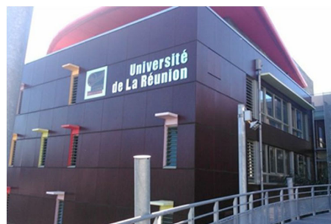
Le bâtiment administratif de l'université
